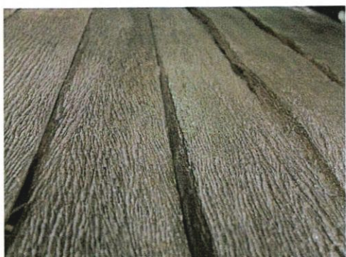
พื้นไม้ตีเว้นร่อง วัสดุไม้เคี่ยม
