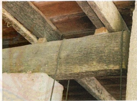
ไม้รอง ไม้ตั้งให้อยู่ในระนาบเดียวกัน วัสดุไม้ตาลโตนด
