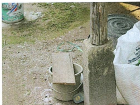
ดินส่ายกสูงป้องกันน้ำท่วม วัสดุคอนกรีต
