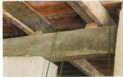
ตงไม้ แผ่นรองไม้ เพื่อให้มีระนาบเดียวกัน
