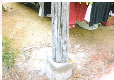
เสาไม้ยาววางบนดินเสาคอนกรีต วัสดุไม้เคี่ยม
