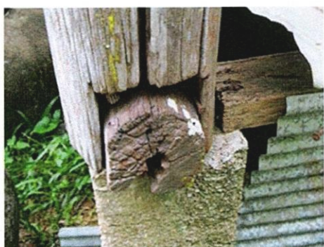
หัวเสา บากไม้สอดคาน เพื่อความแข็งแรง วัสดุไม้เคี่ยม
