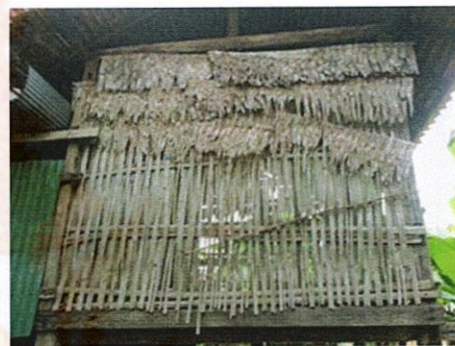
ฝาผนังไม้ไผ่ขัดตะ วัสดุไม้ไผ่
