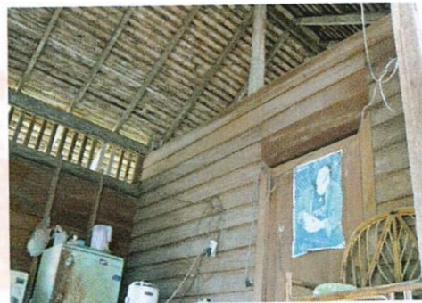
ฝาผนังตีซ้อนเกล็ด วัสดุไม้ตาลโตนด
