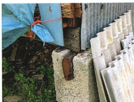
ดินเสาบากหัว เพื่อยึดคาน วัสดุคอนกรีต
