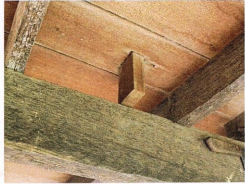
เสาไม้ยาว วางบนดินเสาคอนกรีต วัสดุไม้เคี่ยม
