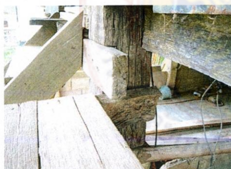
เสาไม้บาก ยึดคาน เพื่อความแข็งแรง วัสดุไม้เคี่ยม
