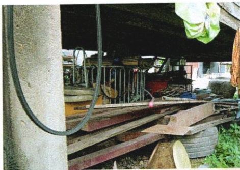
ดินเสายกสูง ป้องกันน้ำท่วม วัสดุคอนกรีต
