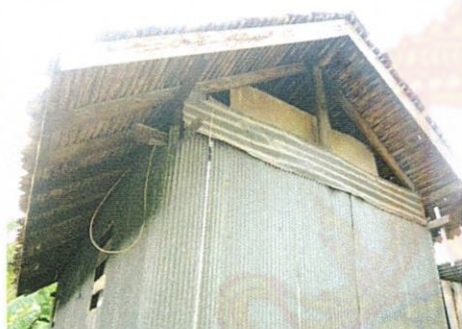
ฝาผนังสังกะสีเพื่อรับแรงลมที่มาประทะตัวเรือน วัสดุสังกะสี
