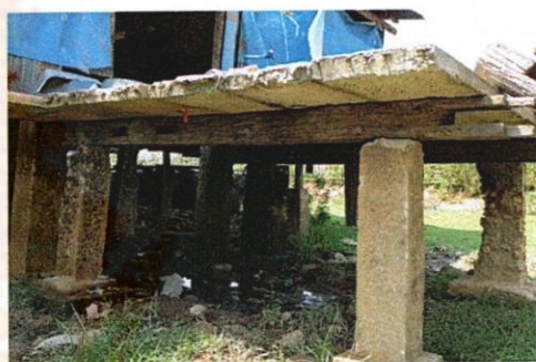
ดินเสายกสูง ป้องกันน้ำท่วม วัสดุคอนกรีต
