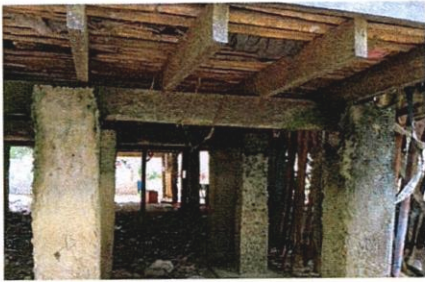
ดินเสายกสูง เพื่อป้องกันน้ำท่วม วัสดุคอนกรีต
