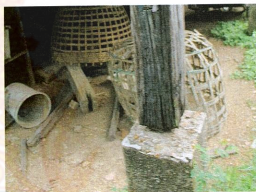
เสาไม้วางบนดินคอนกรีต วัสดุไม้เคี่ยม
