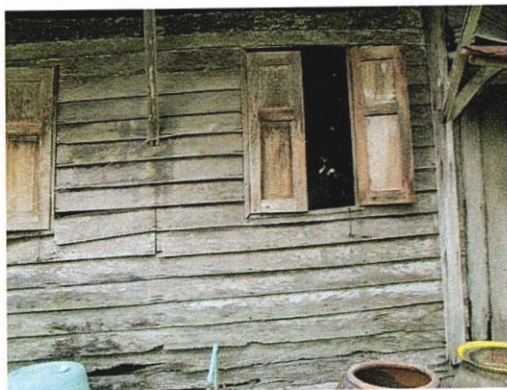
ฝาผนังตีซ้อนเกล็ด วัสดุไม้ตาลโตนด
