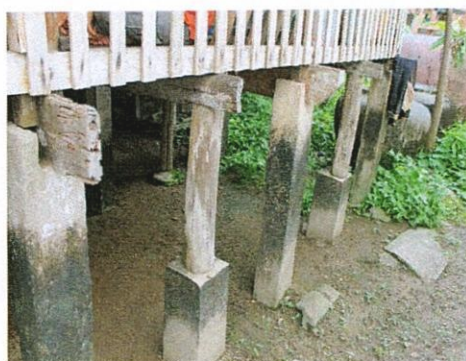
เสาไม้ยาว วางบนดินเสาคอนกรีต วัสดุไม้เคี่ยม
