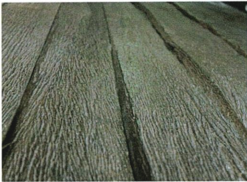
พื้นไม้ตีเว้นร่อง เพื่อให้ลมเข้าภายในตัวเรือน วัสดุไม้เคี่ยม
