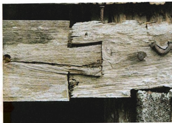
คานไม้เข้าเดือยแบบจิกขอ เพื่อความแข็งแรงของตัว
