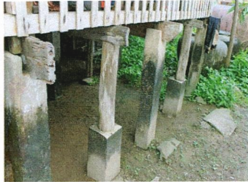
เสาไม้ยาว วางบนดินเสาคอนกรีต วัสดุคอนกรีต
