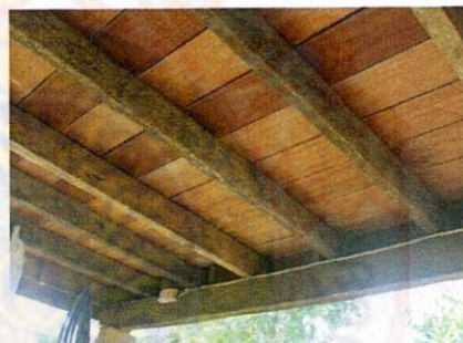
พื้นไม้ตีขัด วัสดุไม้ตาลโดนด
