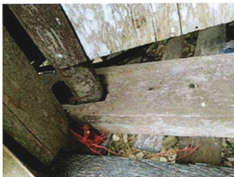
วงกบไม้ เข้าเคื่อยเขะร่อง ยึดบานประตู วัสดุไม้
