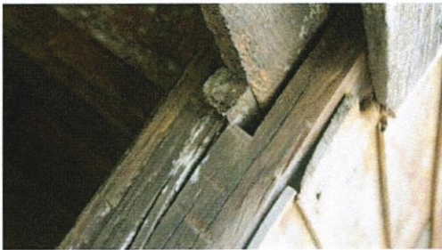
เสาไม้ บากเพื่อยึดคาน ให้มีความแข็งแรง วัสดุไม้เคี่ยม
