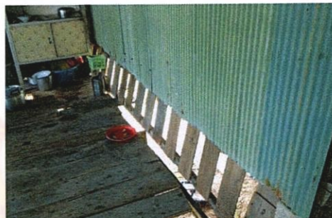
ช่องแมวลอด เพื่อระบายอากาศ วัสดุไม้ตาลโตนด
