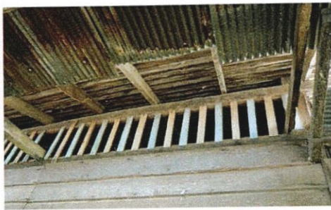
ช่องระบายอากาศใต้หลังคา วัสดุไม้ตาลโตนด
